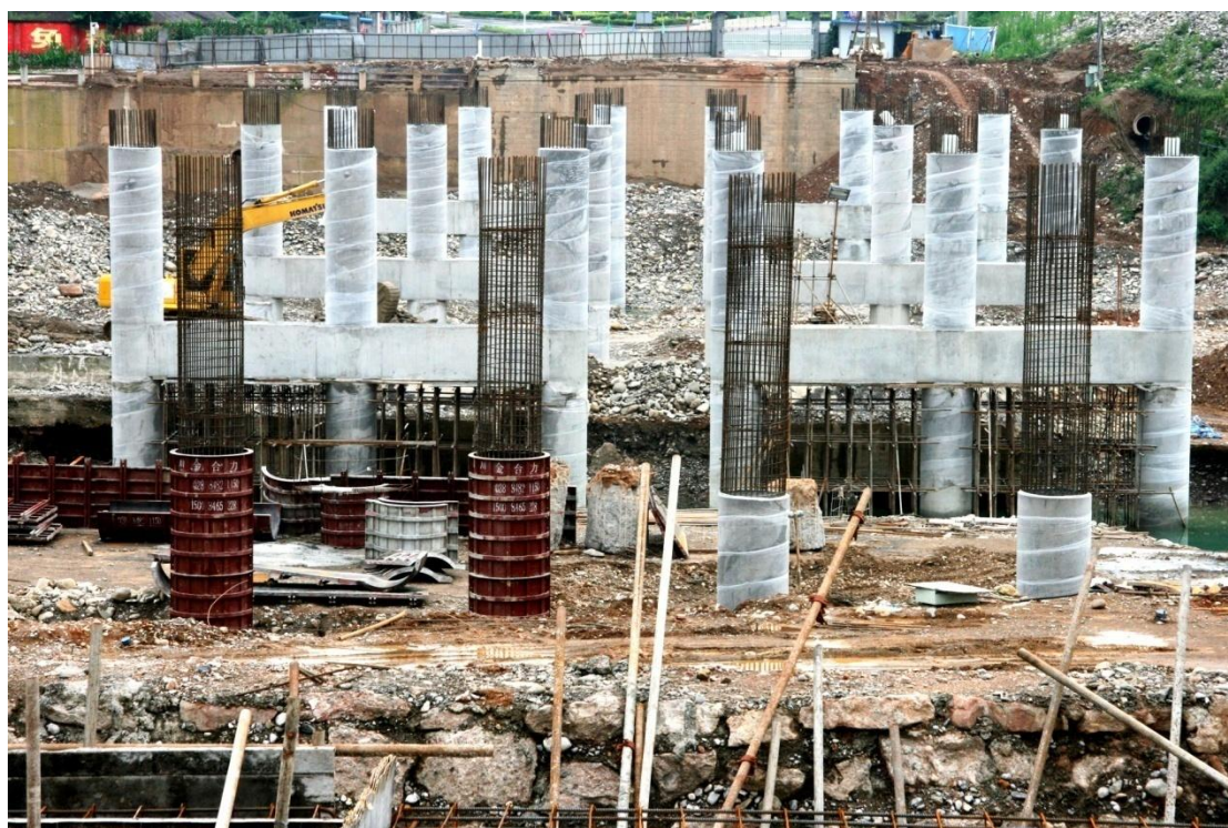
安昌河大桥墩柱的浇筑情况
