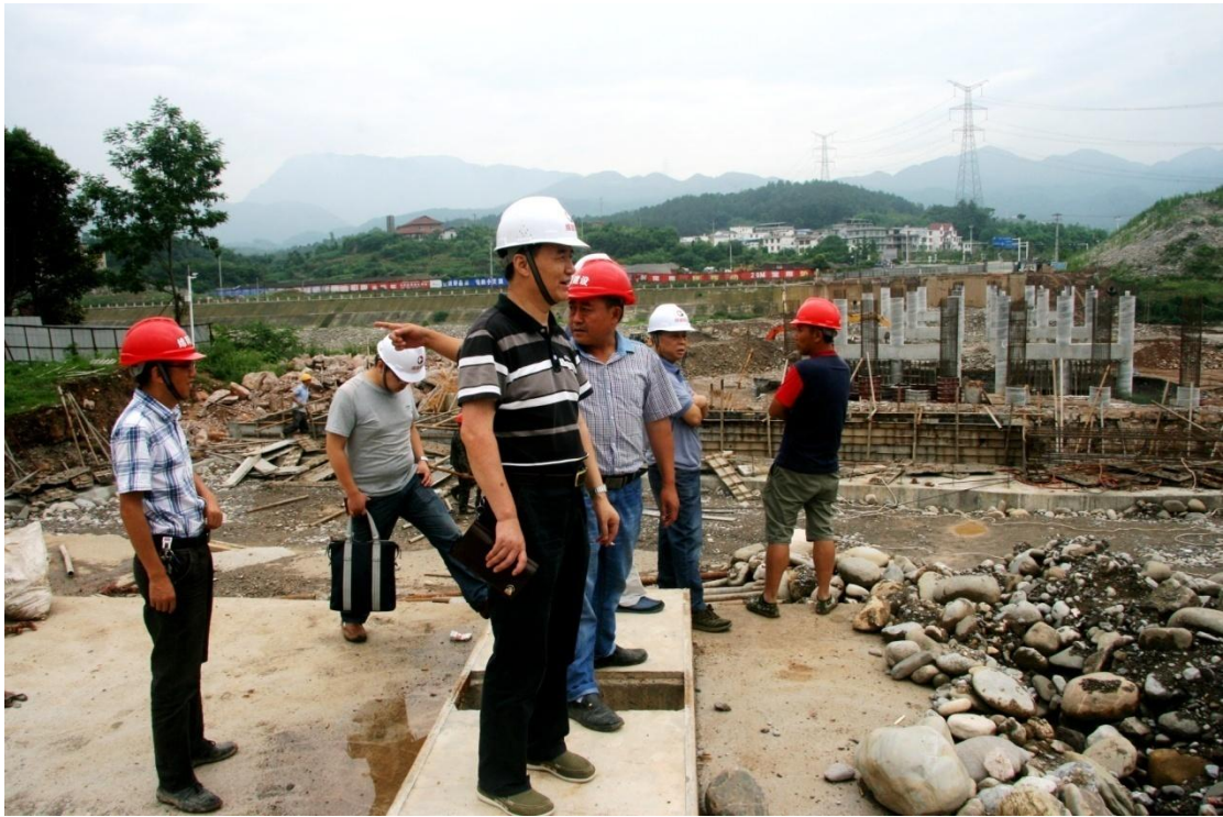
检查组认真查看工地
