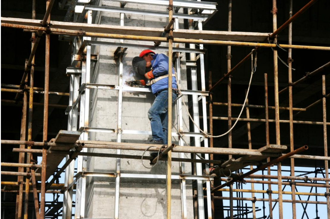
工人高空焊接作业
