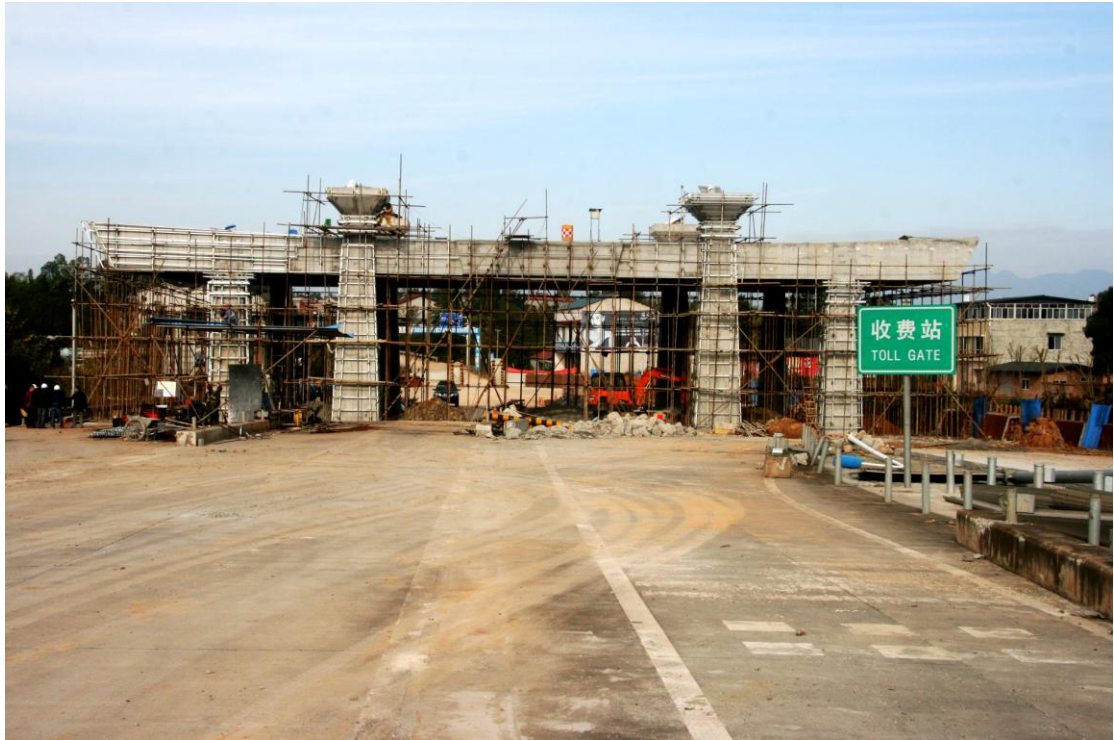
收费站主体完工，进入装修阶段
